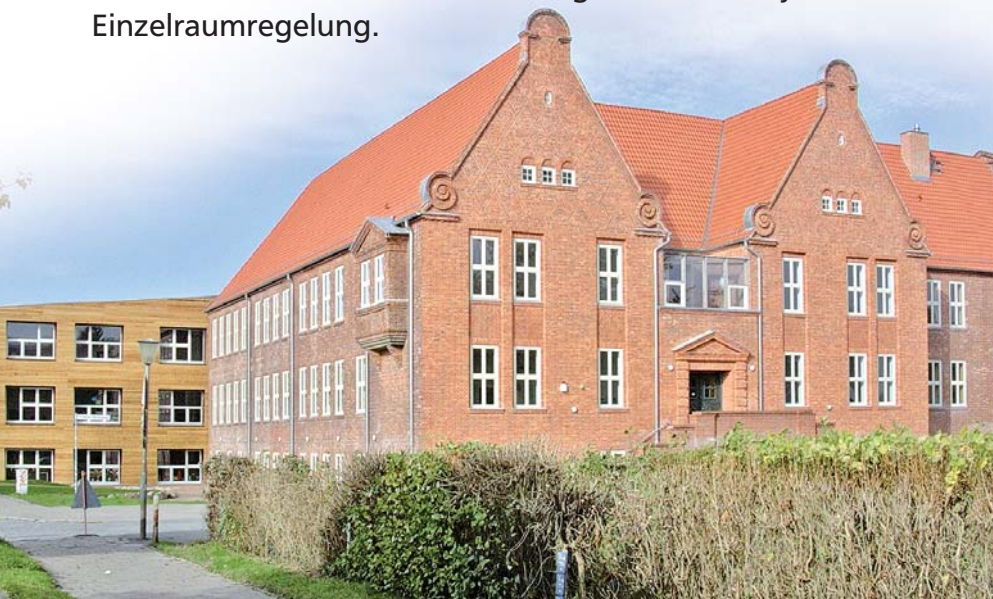
Alt- und Neubau der Jona Schule in Stralsund werden per Fußleistenheizung beheizt. Die Regelung erfolgt über die thermozyklische Einzelraumregelung.
